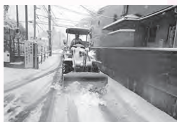
災害協定による除雪作業
