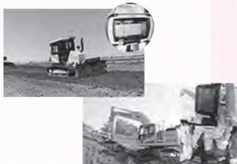
ICT建機による施工
