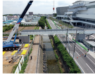
長大橋の建設
