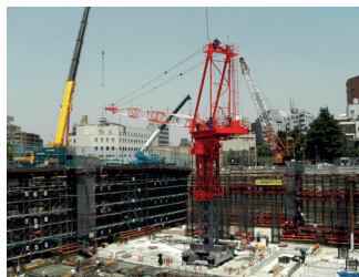
Khung cảnh xây dựng
