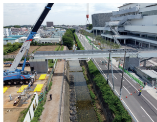
Xây dựng cầu dài
